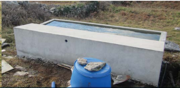
Is féidir píopa a chur sa bpoll sa tanc le é a líonadh ón tobar. Hole in tank allows pipe to be attached facilitating fill from spring.
